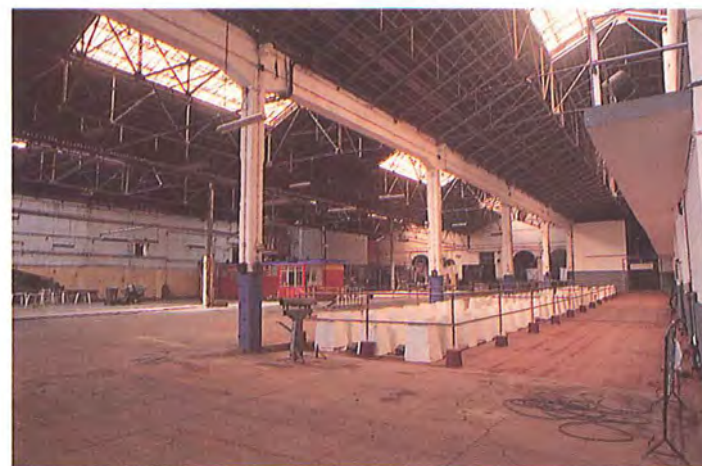
115 — Interior actual dos armazéns
