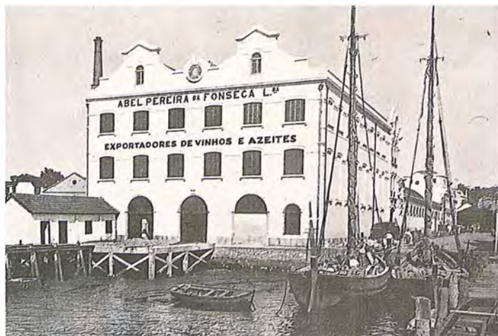
121 — Edifício e cais privativo. Álbum comercial de 1928. Foto Mário Novais
