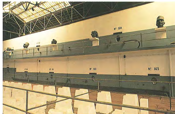
54a — Interior do Armazém Abel Pereira da Fonseca/Warehouse's interior
