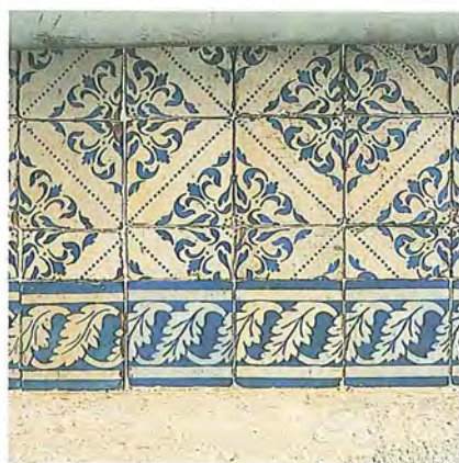
Rua do Grilo. Prédio de Manutenção Militar. Padrão azul e branco com ponteados. Fábrica Roseira. Séc. XIX (2.ª metade).
