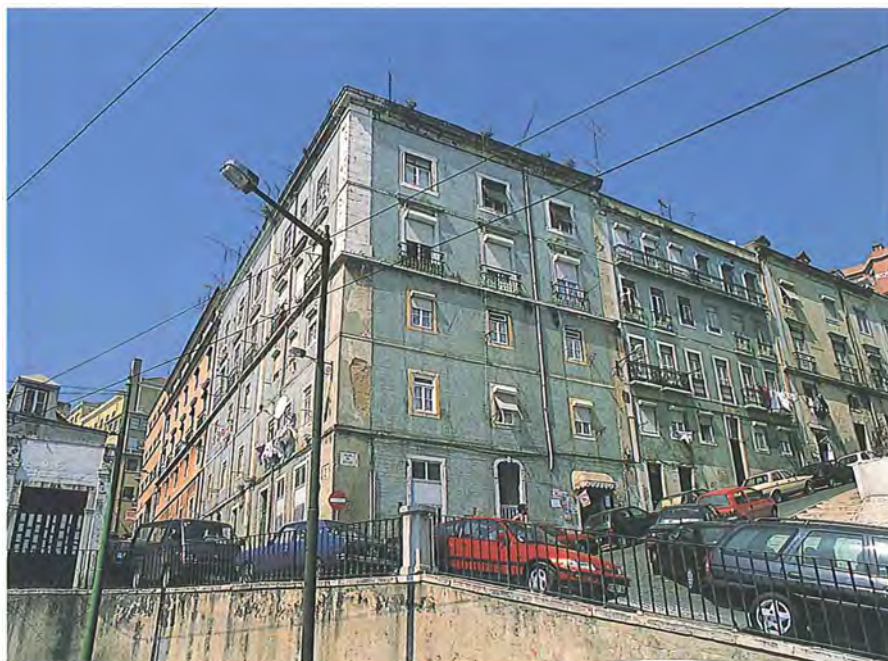
Prédio de gaveto. Calçada dos Cesteiros. Perspectiva da fachada azulejada.
