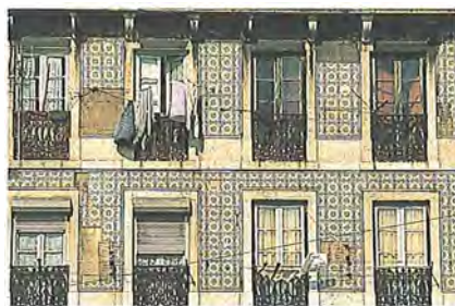
Largo dos Caminhos de Ferro. Fachada azulejada (pormenor). Fábrica Constância (?). Séc. XIX (2.ª metade).
