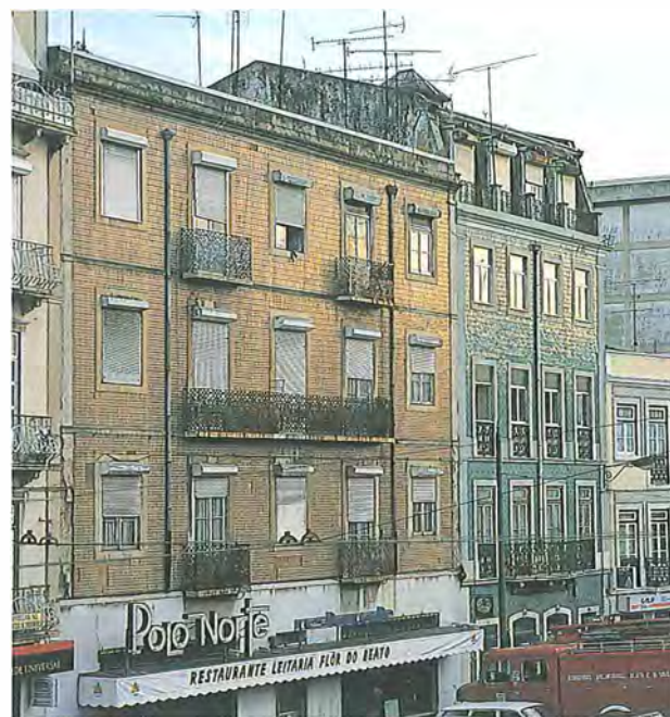
Rua do Grilo. Conjunto de fachadas azulejadas. Da esquerda para a direita: Fábrica de Sacavém (?), Fábrica Viúva Lamego (?) e Fábrica Roseira (?), Séc. XIX (2.ª metade).
