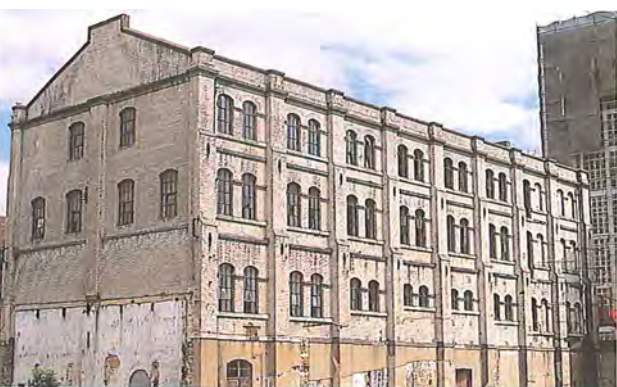
Edifício dos Limpadores.
