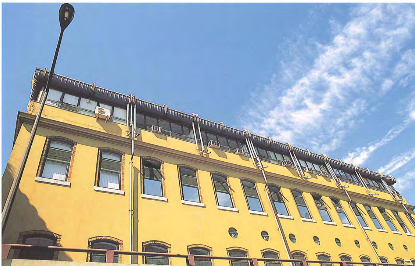
Aspecto actual dos edificios fabris após reconversão do espaço.
