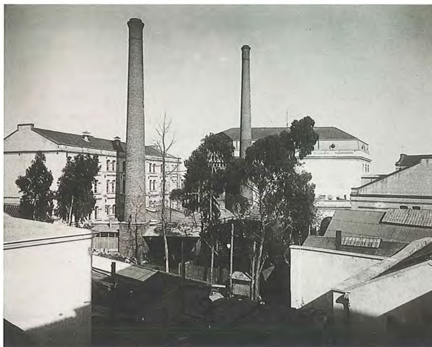
Perspectiva interior do pátio onde se instalaram as casas das caldeiras e das máquinas a vapor. Arquivo de A Nacional.
