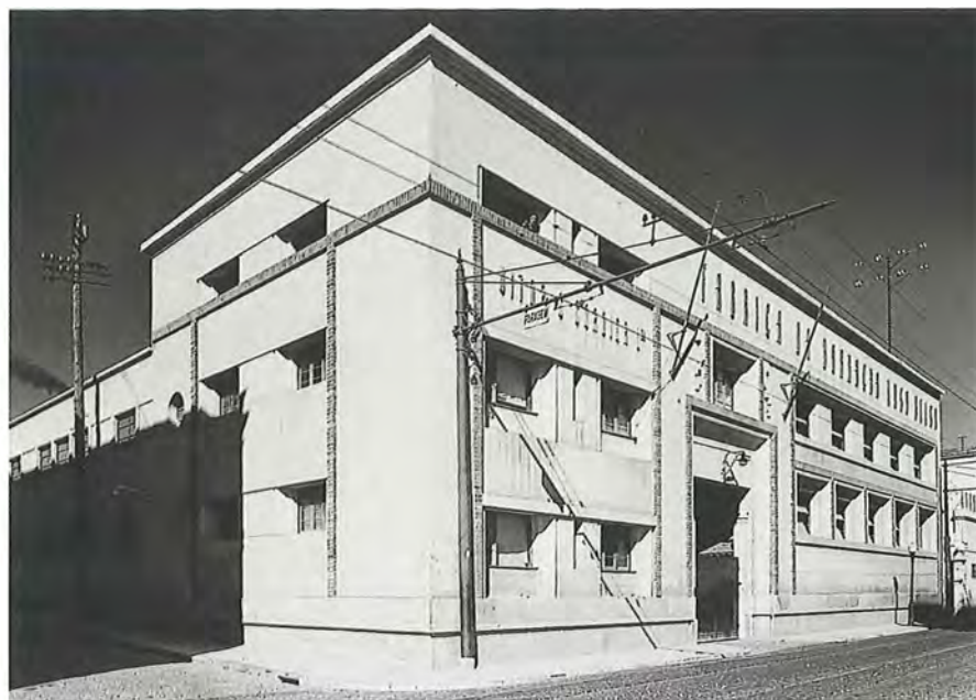
Edifício da Fábrica de Borracha Luso-Belga, com frente para a Rua do Açúcar. Foto Mário Novais. Arquivo de Arte da Fundação Calouste Gulbenkian.
