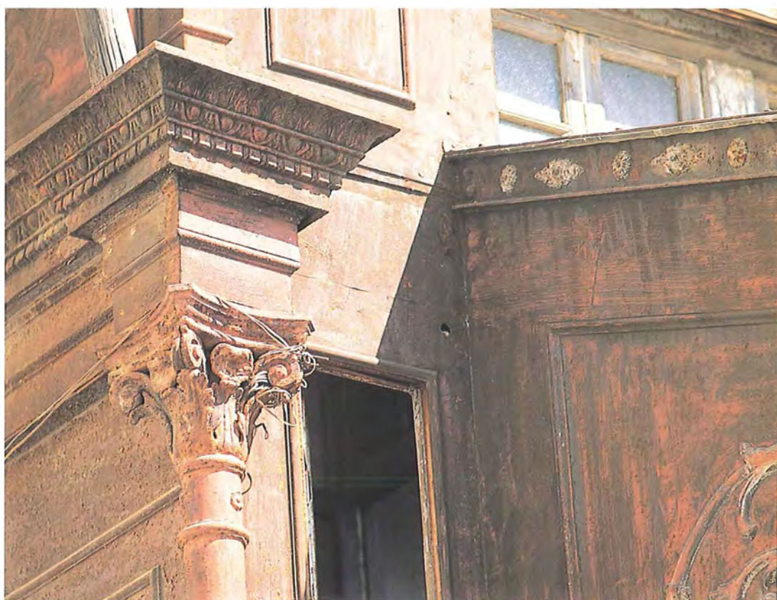
Pormenor da fachada.
