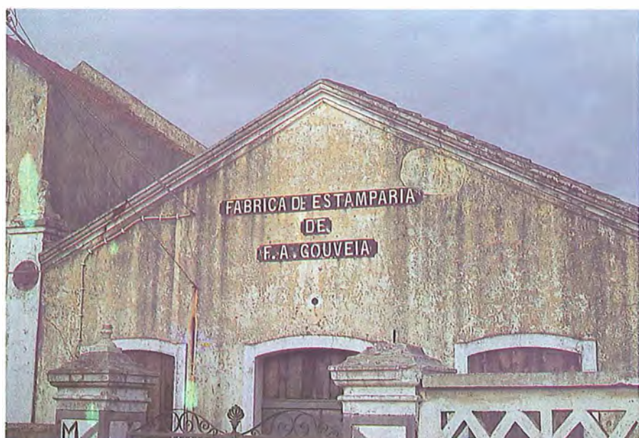
Edifício da fábrica de estampa. Foto Rui Rasquilho. 1978.
