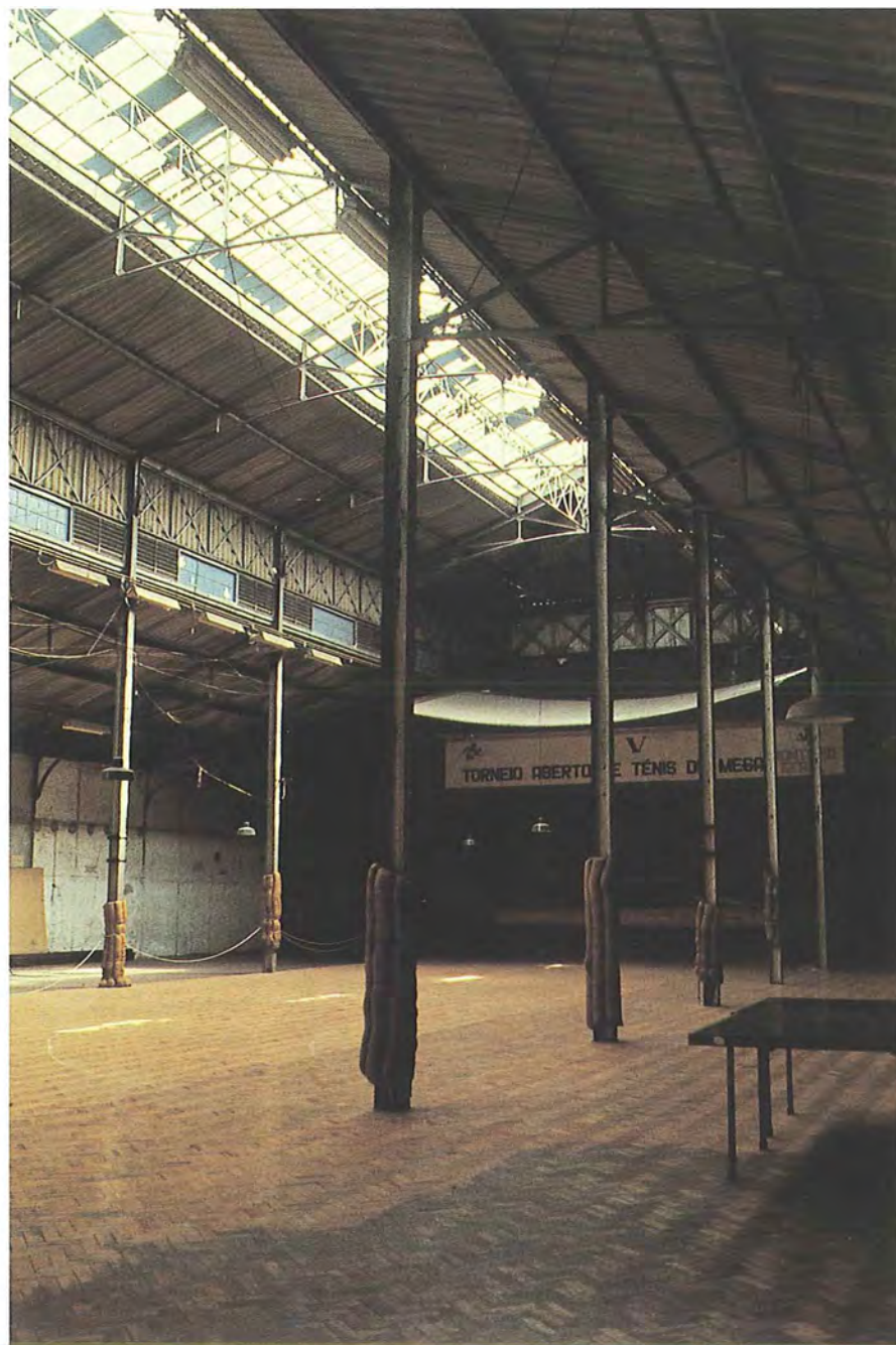
Nave interior do edifício da Tabaqueira. Foto Irene Buarque. 1983.
