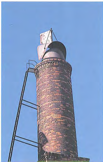
Chaminé da fábrica de malte.
