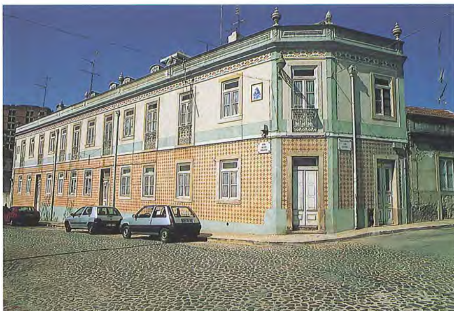
Prédio fronteiro à igreja.
