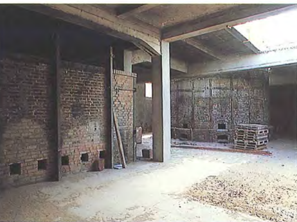
Interior do espaço do futuro museu, onde se localizam duas estruturas de combustão in situ .
