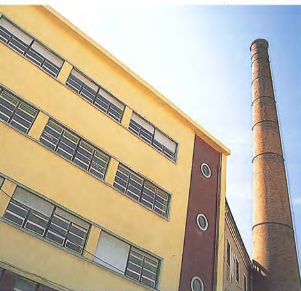
Pormenor da fachada modernista.
