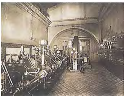
Central termoelectrica, com máquina a vapor Sulzer. Anos 20. Arquivo de A Nacional.
