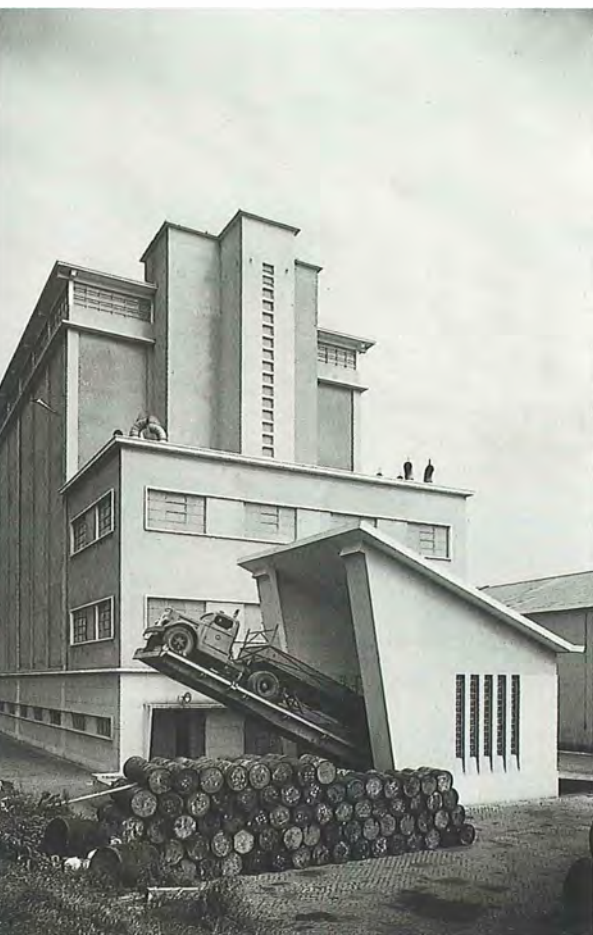
Silos e serviços anexos. Foto Mário Novais. Arquivo de Arte da Fundação Calouste Gulbenkian.
