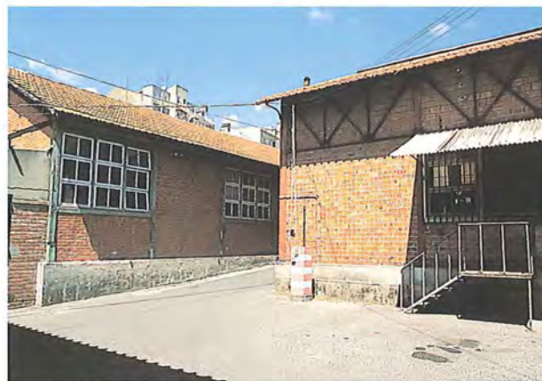
Edifícios das antigas oficinas. Estado actual.
