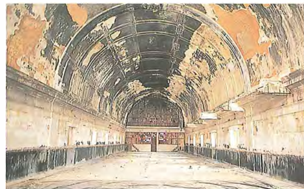
Perspectiva actual dos vestígios das cuvas de têmpera e dos tanques de germinação.
