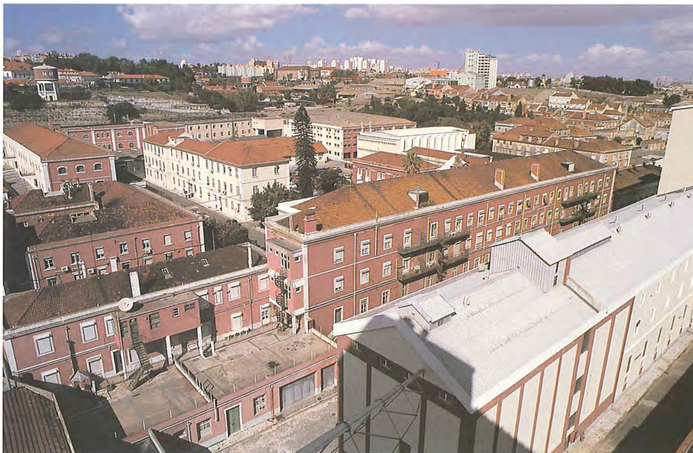
Manutenção Militar. Perspectiva vista dos silos.
