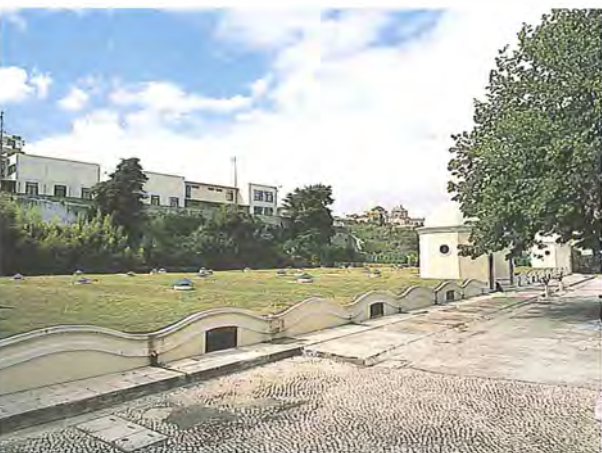
Reservatório dos Barbadinhos I.
