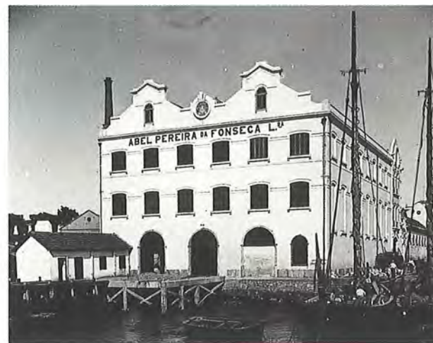
Edifício da firma APF. 1910. Foto Mário Novais. Arquivo de Arte da Fundação Calouste Gulbenkian.
