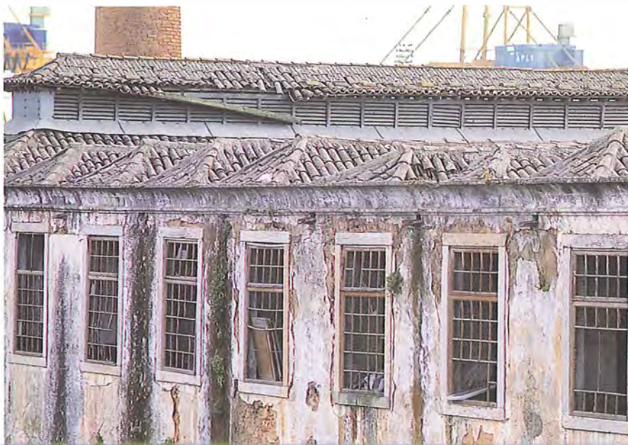
Perspectiva actual da cobertura.
