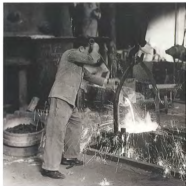
Oficina de fundição. Sangria do cubilot. Foto Mário Novais. Arquivo de Arte da Fundação Calouste Gulbenkian.
