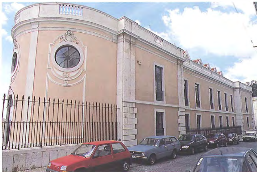
Palácio do Quaresma-Alvito. Fachada sobre a Rua da Cruz de Santa Apolónia, com o acrescento da caixa redonda da escadaria, posterior a 1875.
