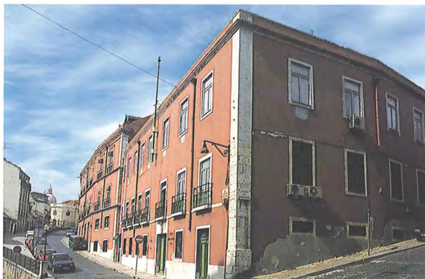
Vista lateral de conjunto do Palácio Veloso, tendo em primeiro plano o edifício anexado ao conjunto depois da abertura da Calçada dos Barbadinhos.
