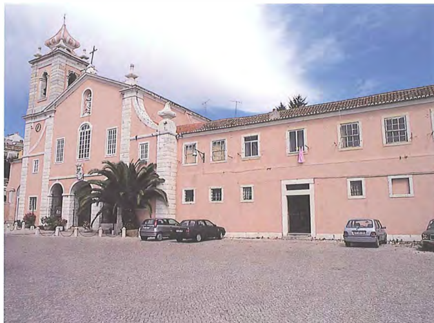
Vista de e conjunto da fachada do antigo Convento dos Barbadinhos italianos. Na página ao lado alguns pormenores do conjunto, e fachada lateral do convento, sobre a Rua do Alviela.
