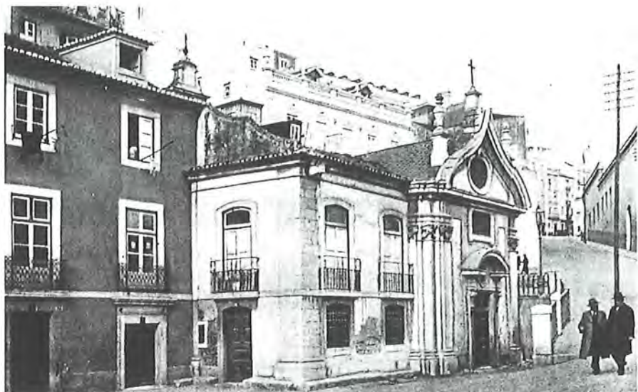
Ermida da Boa Nova, fotografia publicada em A Ribeira de Lisboa , de Júlio de Castilho, podendo apreciar-se ainda em razoável estado de conservação o conjunto do edifício, com o corpo anexo que albergava a sacristia, no piso inferior, e a Casa do Despacho da Irmandade, no piso superior.
