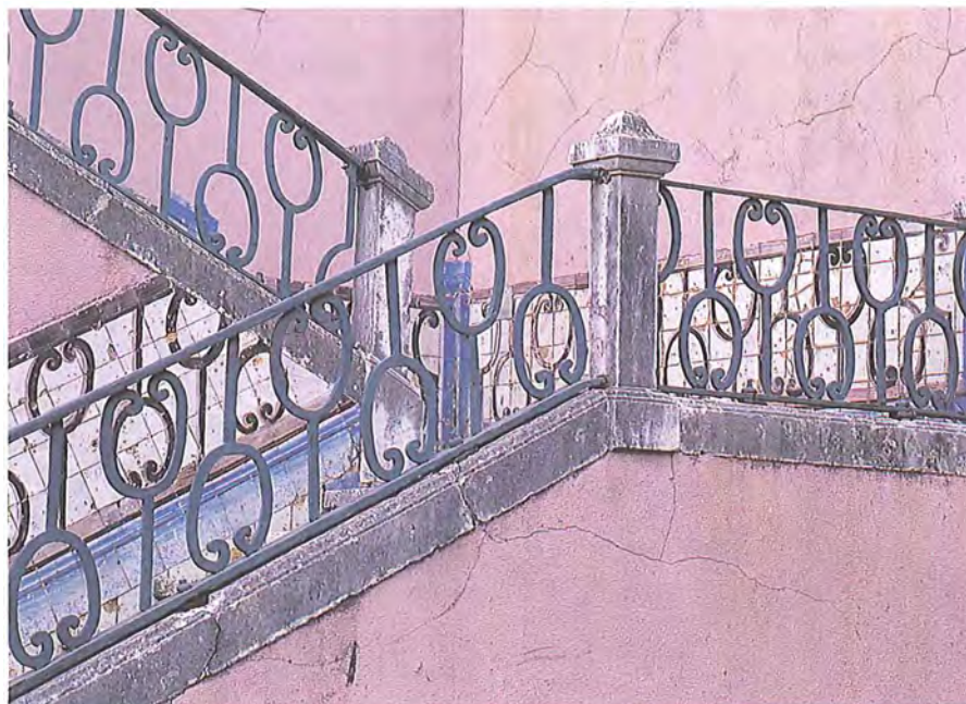
Pormenor da mesma escada, com azulejos que repetem em tromp-l'oeil o desenho das guardas.
