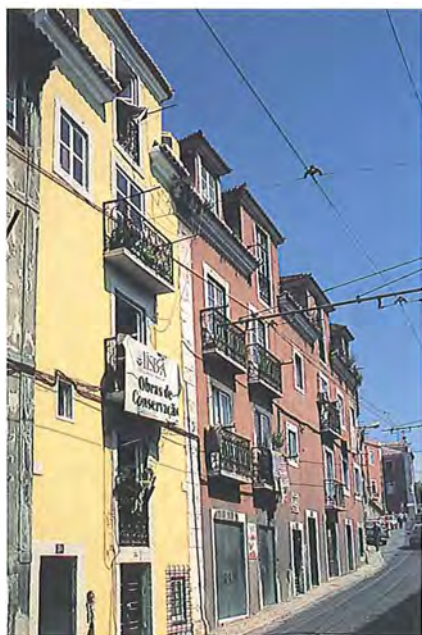
Calçada de Santa Apolónia. Em cima: casa dos Teles de Meneses (?). Em baixo: renque de prédios municipais.
