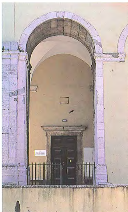
Arcaria inacabada da primitiva galilé de acesso à projectada igreja.
