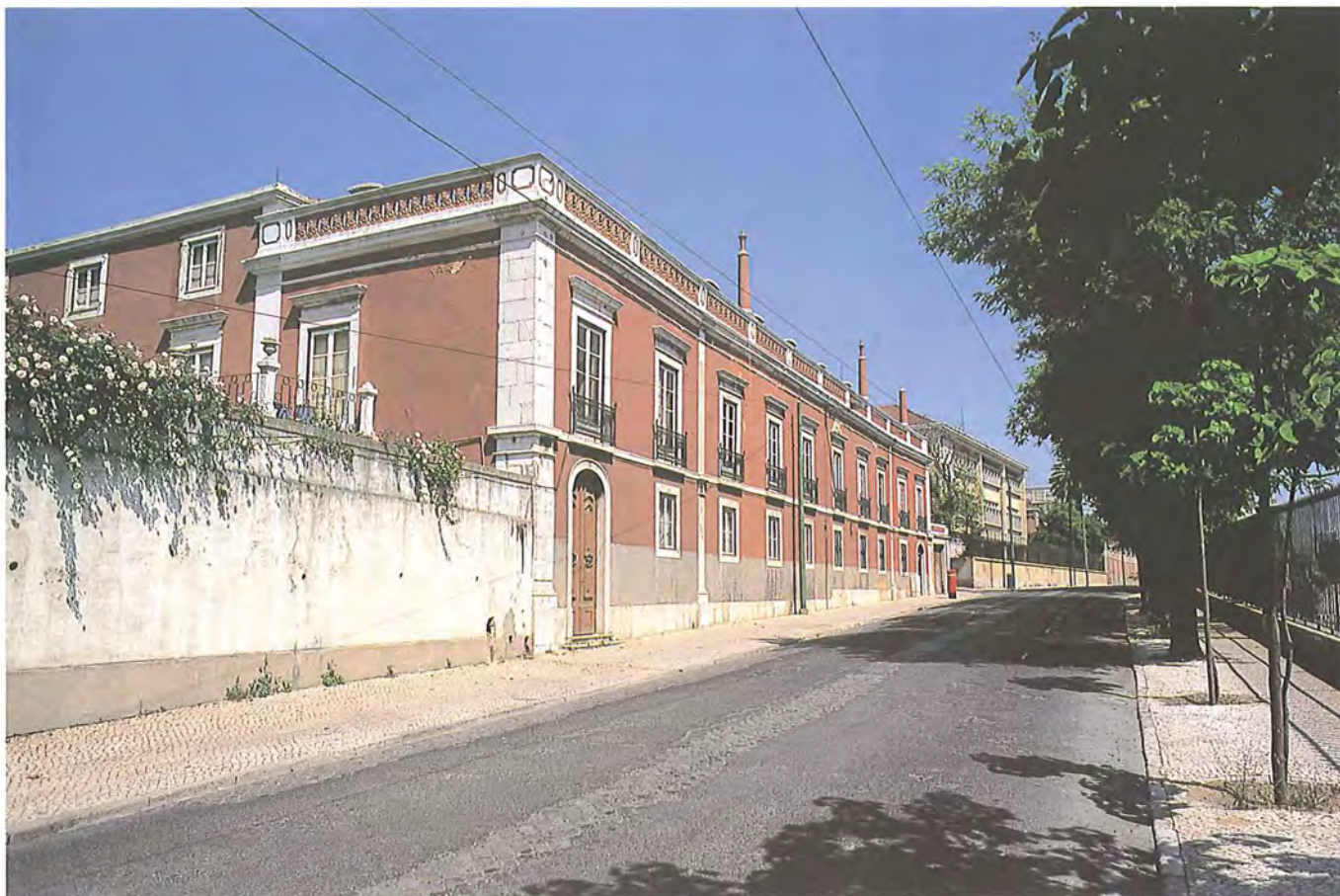
Fachada sobre a Calçada da Cruz da Pedra.
