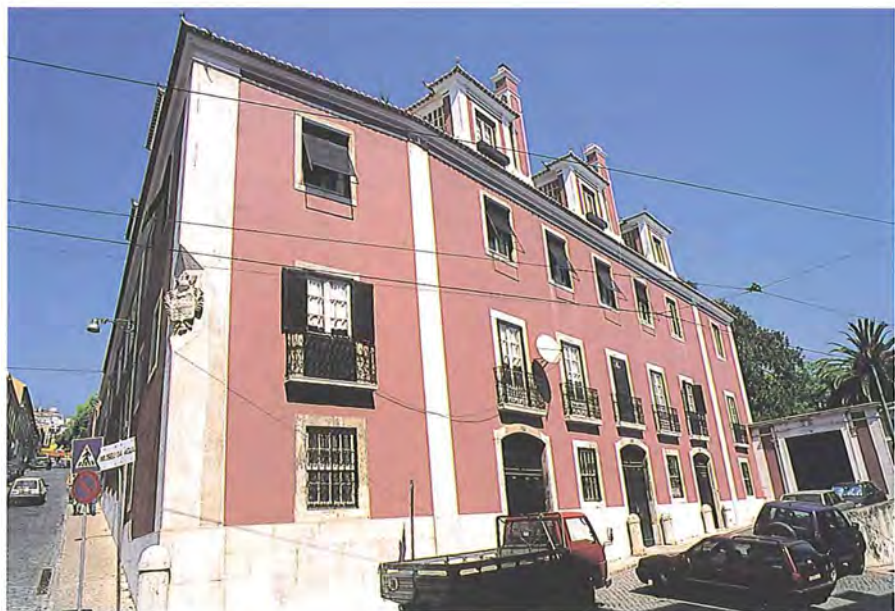
As casas pequenas dos senhores de Pancas, como são referidas na documentação, situavam-se junto à antiga entrada da quinta, esquinando para a Calçada dos Barbadinhos. Esta propriedade, hoje autonomizada após a venda do palácio à CML, foi muito aumentada nas suas dependências por iniciativa da família Pereira Palha, ao longo do século XIX, continuando na posse dos seus descendentes, hoje família Pereira Palha Van Zeller.
