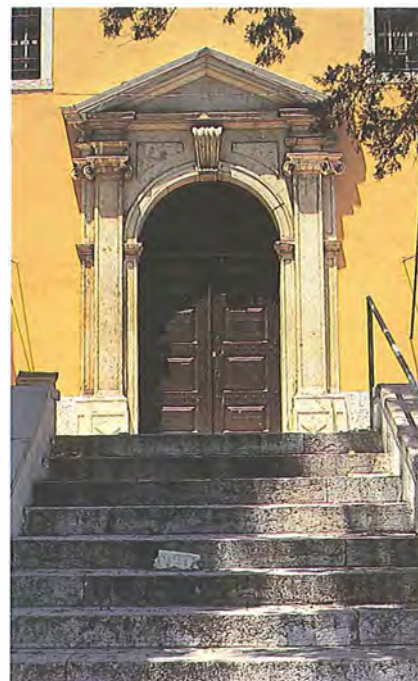
Portal de acesso à igreja actual. Note-se que o frontão triangular que coroa o portal não está representado no desenho acima.
