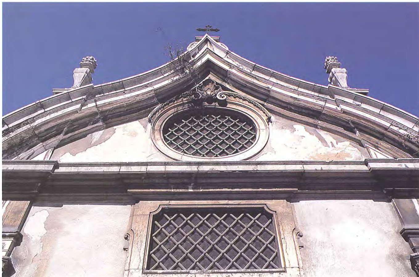
Coroamento da fachada da Ermida da Boa Nova.
