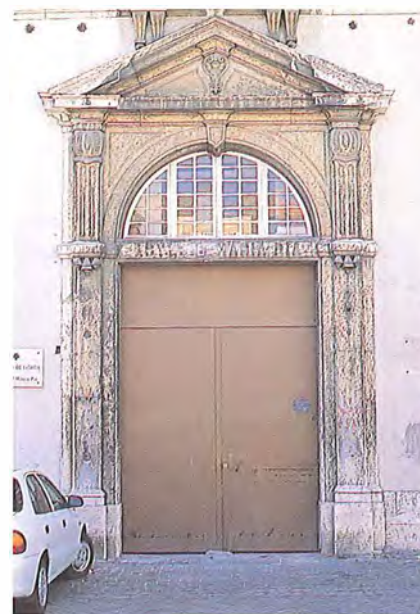
Portal nobre de acesso ao pátio.
