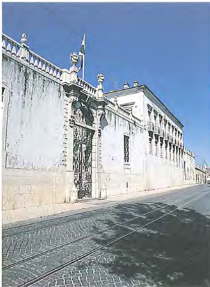
Vista exterior do Palácio da Mitra.
