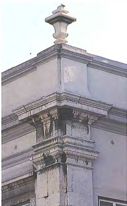
Pormenor da cimalha e coruchêu.
