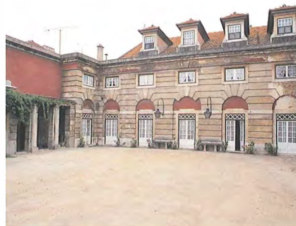
Palácio Lafões: duas vistas das fachadas sobre o pátio. Em cima, o conjunto possivelmente erguido já no século XIX, com acesso ao salão sobre o jardim; em baixo, fachada lateral com o revestimento em junta fendida, a única que obedece ao desenho do projecto de reconstrução pós-terramoto.
