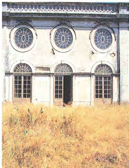
Palácio Lafões: em cima, o corpo primitivo seiscentista da quinta dos Mascarenhas, notando-se no piso térreo sobre a rua a justaposição de um revestimento de cantarias, de acordo com o projecto de renovação pós-terramoto; em baixo, a fachada do salão sobre o jardim, construído já no século XIX.
