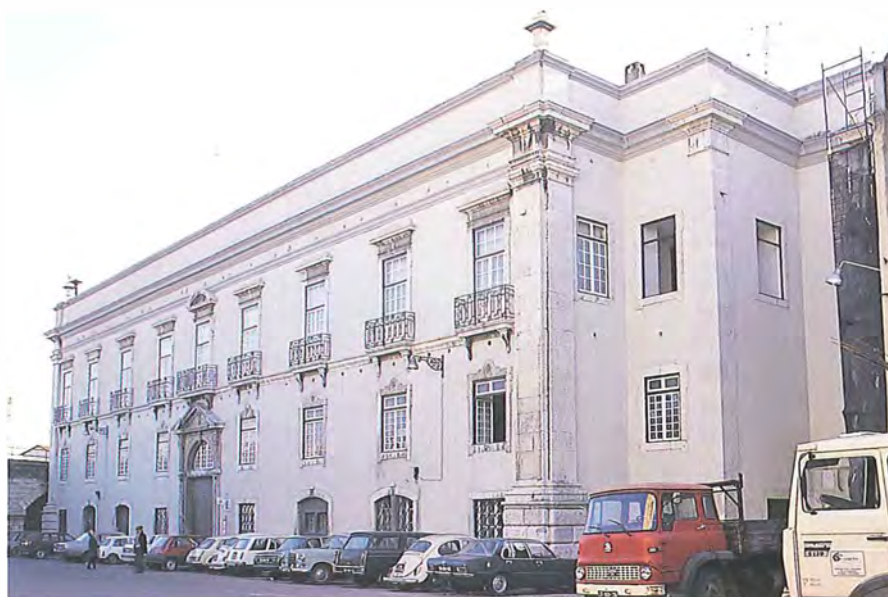
Fachada norte do palácio sobre o Largo do Marquês de Nisa, antigo Terreiro de Xabregas, com o portal de acesso ao pátio.
