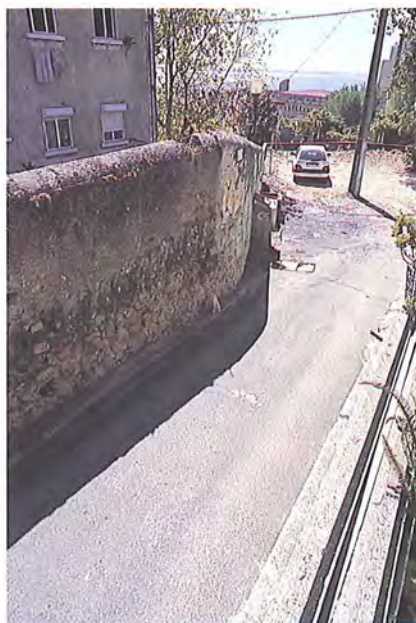
Em cima: Escadinhas de D. Gastão, antiga via pública de ligação à zona da Ilha do Grilo.
