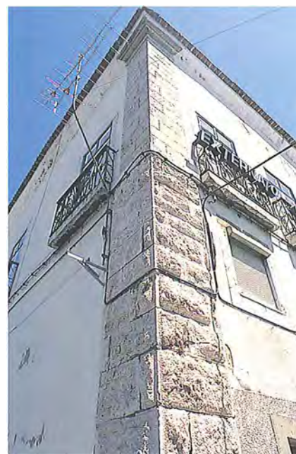
Cunhal da casa da Quinta Leite de Sousa. A parte inferior em cantaria rusticada corresponde ao edifício inicial, depois acrescentado com o arranjo mais tardio do piso nobre, com o cunhal agora talhado em cantarias lisas, sem ter havido portanto qualquer vontade de conformar a parte nova ao gosto preexistente.
