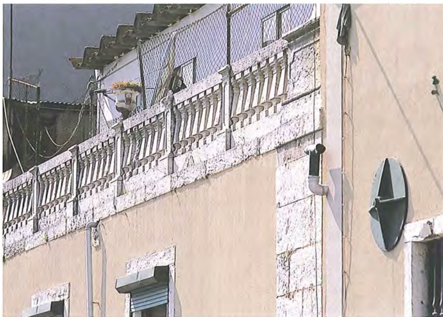
Restos do antigo muro de suporte da varanda sobre o cais, com a primitiva balaustrada setecentista.
