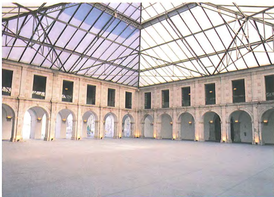
Em cima: corredor do primeiro andar do claustro. Em baixo e na página ao lado: vista geral e pormenor da arcaria do claustro do Beato, erguido já no início do século XVIII.
