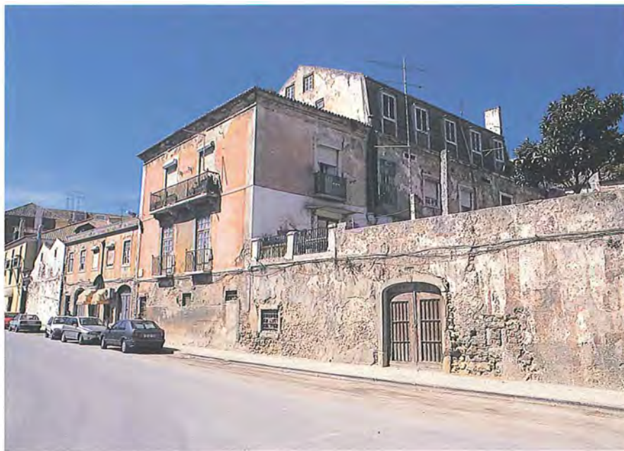
A Quintinha , a antiga casa nobre, destacando-se a varanda sobre o rio e restos de suportes de pedra de uma latada. A o lado, uma porta no pátio da quinta.
