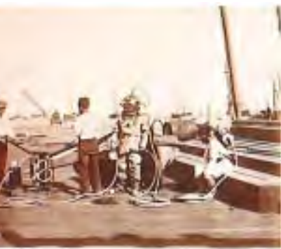
Figura 151 – Mergulhadores armados de escafandro Denoyrouse, in Construção do Caes Oriental do Alfondaga , 1877.
