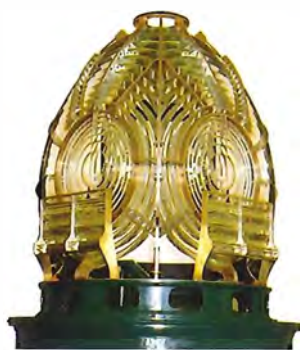
Figura 43 – Aparelho óptico instalado no Farol de Sines, em 1915, com funcionamento a incandescência pelo vapor de petróleo e rotação por mecanismo de relojoaria, construído em França por B. B. T.. O seu alcance luminoso médio era de 30 milhas. Em Janeiro de 1950 foi electrificado, funcionando também como aeromarítimo através da instalação de painéis, ficando com o alcance luminoso de 42 milhas. Foi retirado o 10 de Janeiro de 1993, em virtude da elevação da torre do farol. Paço d'Arcos, Direcção de Faróis.
