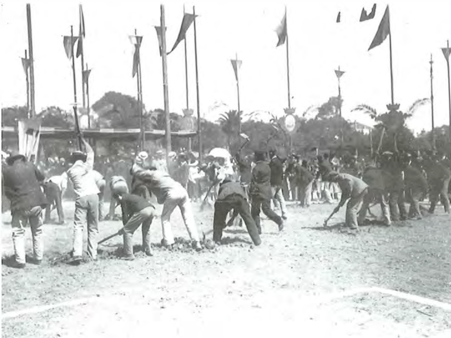
Início dos trabalhos de construção do Monumento ao Marquês de Pombal, 12 de Agosto de 1917, de Joshua Benoliel. Arquivo Fotográfico da Câmara Municipal de Lisboa
