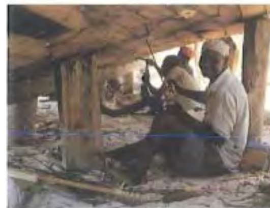
FIG 7 b. Construção de um dhow em Nungwi, Zanzibar, 1994.
