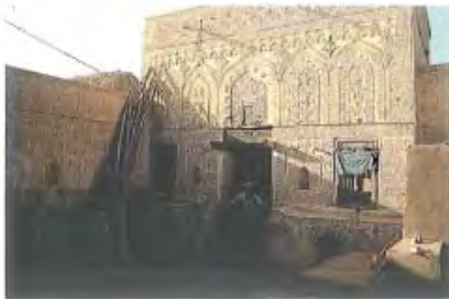
FIG 5. Fachada característica de casa em tijolo, Bayt ao Faqih, Tihama, 1975.
