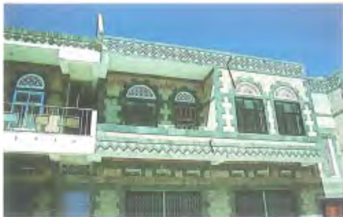
■ FIG 11. Edifício de apartamentos e lojas no piso térreo, Sana, 1990, com estrutura de betão armado e revestimento a pedra serrada.
