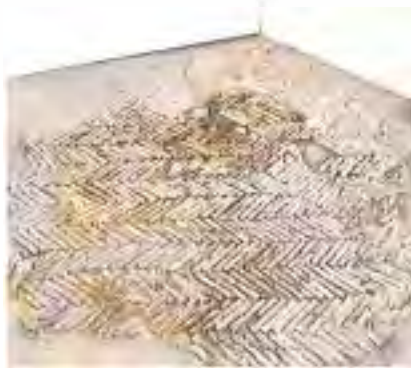
Fig. 13 Pavimento mudéjar, actualmente integrado na Casa dos Bicos
