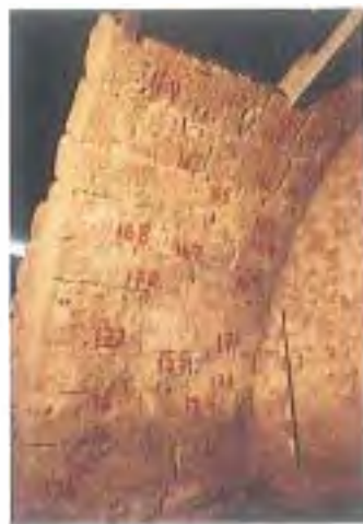
Fig. 10 Arco tardo-medieval em fase de levantamento
