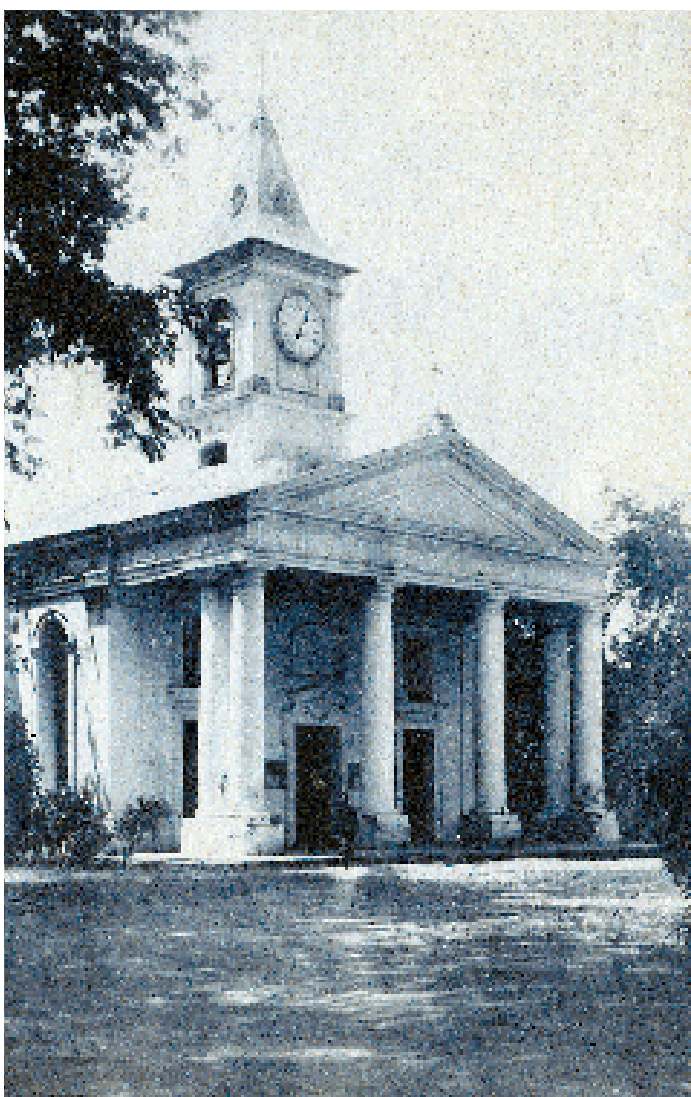
> Edifício da Câmara Municipal de Díli, já desaparecido, (postal editado pela Missão Católica, c. 1935).
