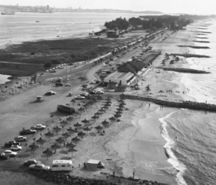
Restaurante Barracuda, Ilha de Luanda, Angola (Foto: © Luís Possolo, década de 1960-70 – demolido)
