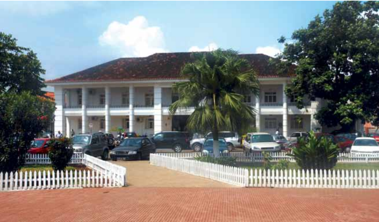
Praça de Portugal, atual Praça da Independência, com Repartição Central dos Serviços de Fazenda e Contabilidade, atual Edifício das Finanças, São Tomé, Mário de Oliveira/GUU, 1951 (Foto: © Ana Vaz Milheiro, 2012)
