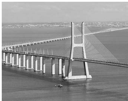
Ponte Vasco da Gama.
