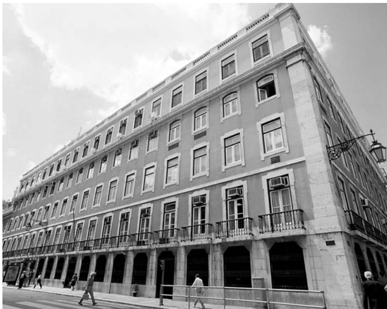
Edifício do Banco de Portugal.
