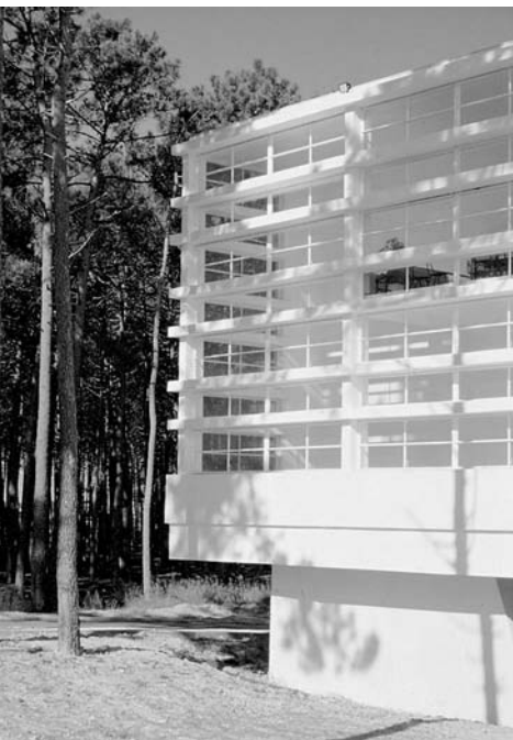
Escola de Artes nas Caldas da Rainha. Projecto de Vítor Figueiredo, 1993-1997.
