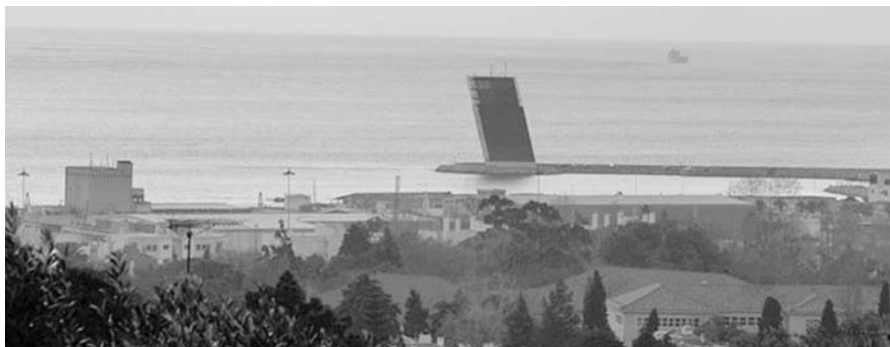
Torre de Controlo do Porto de Lisboa, projecto de Gonçalo Byrne.
