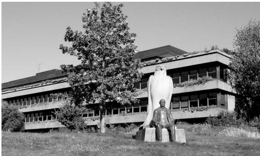
Edifício-sede da Fundação Calouste Gulbenkian, Lisboa.
