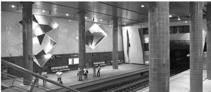
As sucessivas expansões do Metropolitano de Lisboa têm contado com trabalhos de diversos artistas portugueses. No caso, instalação da autoria de Jorge Martins na estação Chelas.
